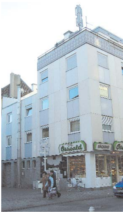
Gebäudedächer in Innenstadtlagen sind beliebte Standorte für Mobilfunkantennen. Bild: Sprengnetter
